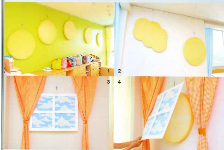
1,2. 丸い形や、雲のような形に切り取られたスポンジのような吸音材。壁にオブジェのように吊るされています。3,4. かわいらしい窓の奥には吸音材が隠れていました。「とても上手にやっていたらいい。気に入っています」(園長先生)
